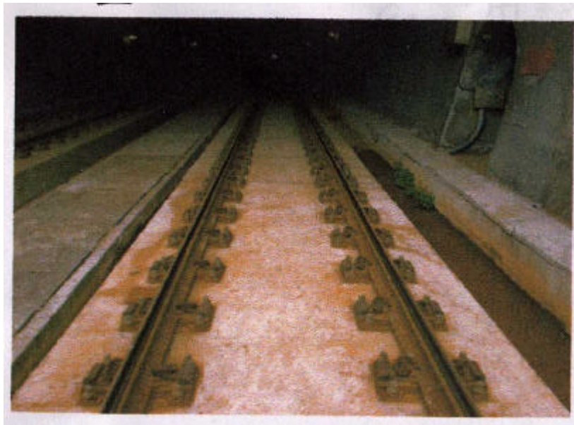
圖 5-7 彈性基鈑軌道圖 (資料來源：東改局工程報告)
