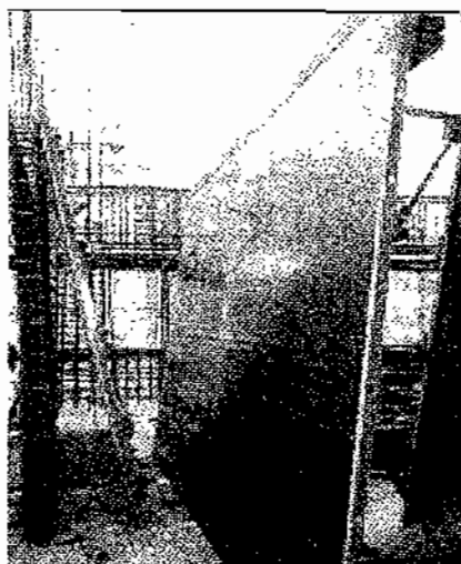
图 A. 0. 3 - 1 钢框胶合板模板示例
